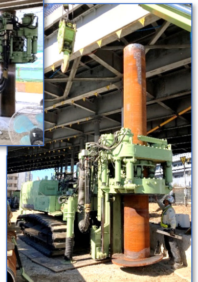
横浜市（跨線橋）
