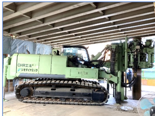
埼玉県（跨線橋）
