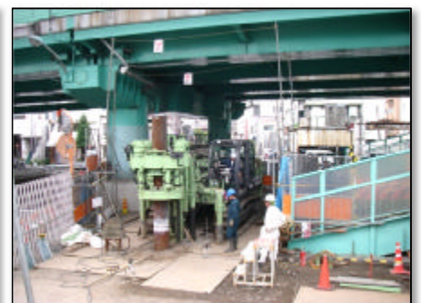
狭隘・空頭制限施工
